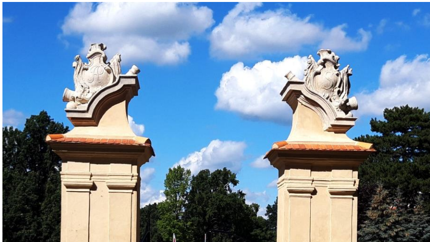
Pylon z katuszem
