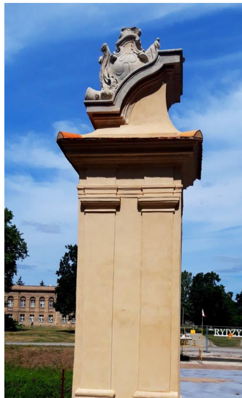
Pylon z katuszem
