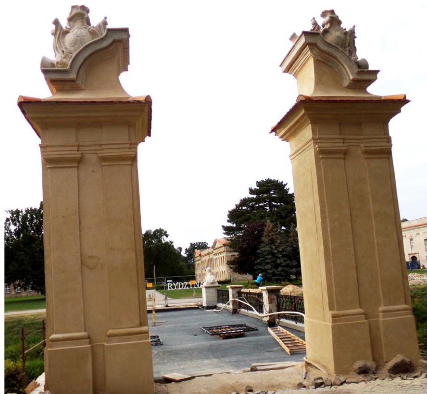
Pylon z katuszem
