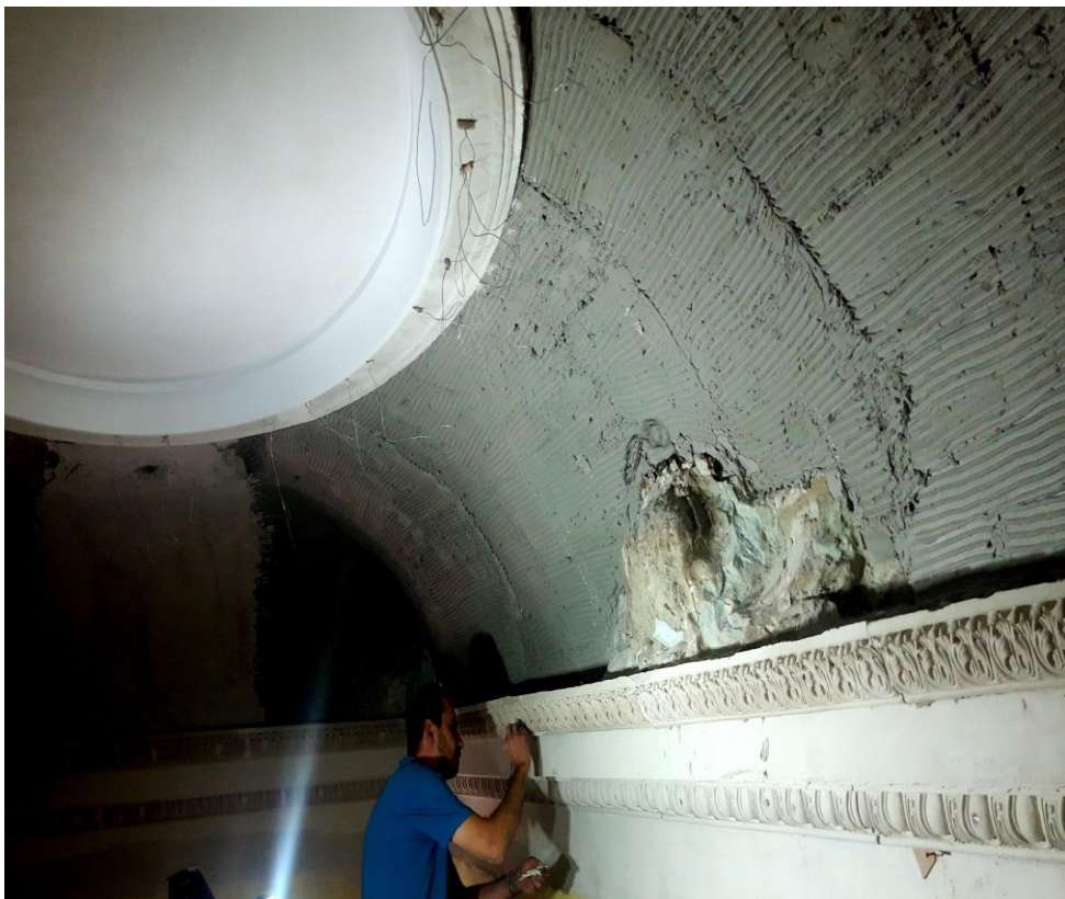
Zamontowany plafon oraz fasety
