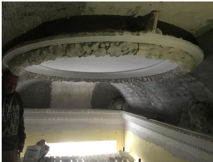
Zamontowany plafon oraz fasety
